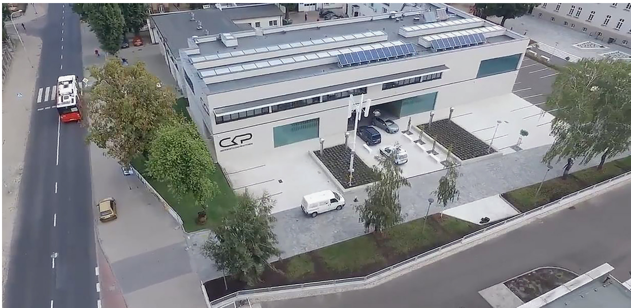
Rycina 12. Przykład realizacji projektu Przebudowa istniejących budynków i rozbudowa budynków Zespołu Szkół Transportowo-Elektrycznych CKU celem utworzenia Centrum Kształcenia Praktycznego wraz z wyposażeniem
