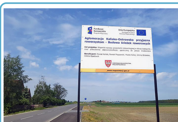
Rycina 8. Przykład realizacji projektu Agglomeracja Kalisko-Ostrowska przyjazna rowerzystom – Budowa ścieżek rowerowych . Inwestycja Krzywosądów–Kuchary
