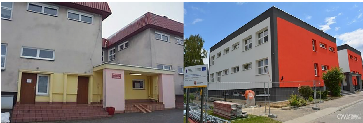
Rycina 10. Przykład realizacji projektu Poprawa efektywności energetycznej budynków użyteczności publicznej Ostrowa Wielkopolskiego . Żłobek miejski przy ul. Jankowskiego przed modernizacją i po
