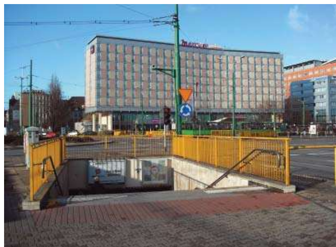
Fot. 5. Zejście do przejścia podziemnego na rondzie Kaponiera
