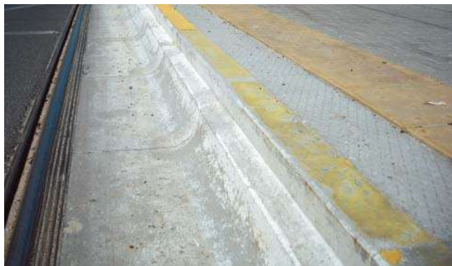
Fot. 2. Krawężnik typu TA (Poznań, ul. Winogrody)
