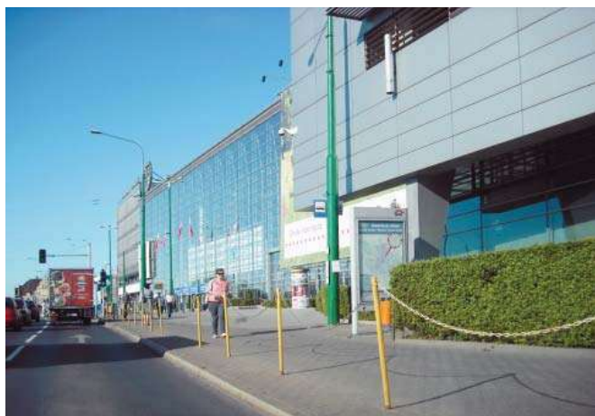
Fot. 4. Przystanek nocny „Most Dworcowy” oddzielony od jezdni łańcuchami – tylko na krótkim odcinku usunięte zostały łańcuchy i wymiana pasażerów może odbywać się tylko jednymi drzwiami
